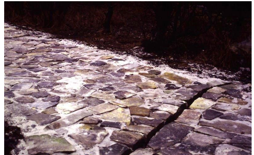
Pavage en grès seulement au niveau de la grande mare. Travaux ONF demandés par NE en commission des « réserves naturelles » de la forêt de Fontainebleau.
