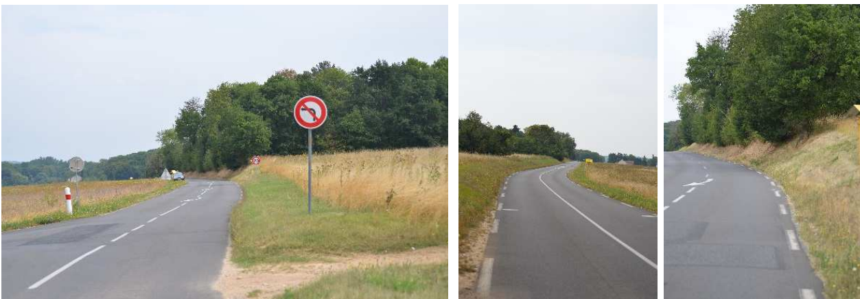
Figure 4 : Photos de la zone de traversée, D17 entre Champigny et le lieu-dit Les Croubis
