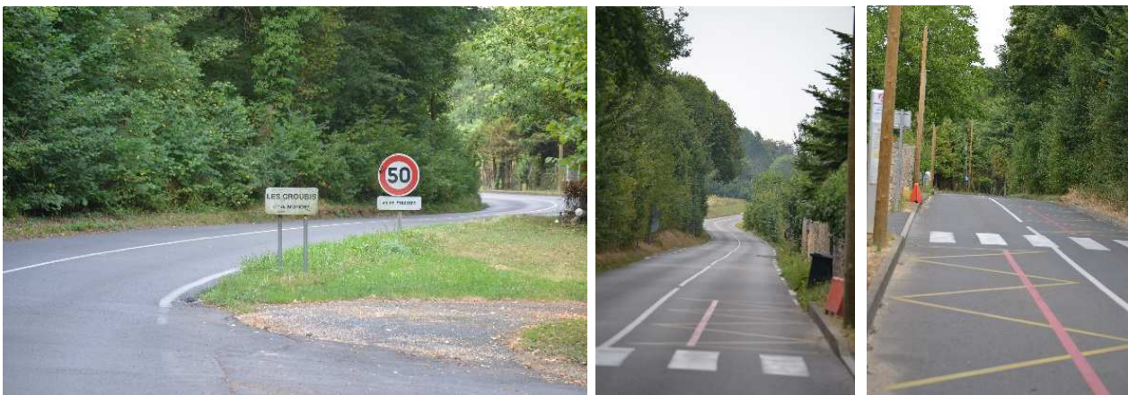
Figure 3 : Photos de la zone de traversée, D17 au niveau du lieu-dit Les Croubis, Champigny-Morigny
