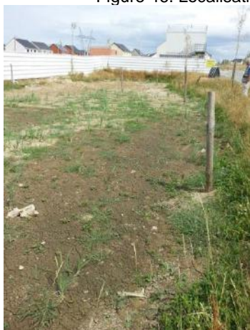
Figure 47. bassin de rétention 91207_008
